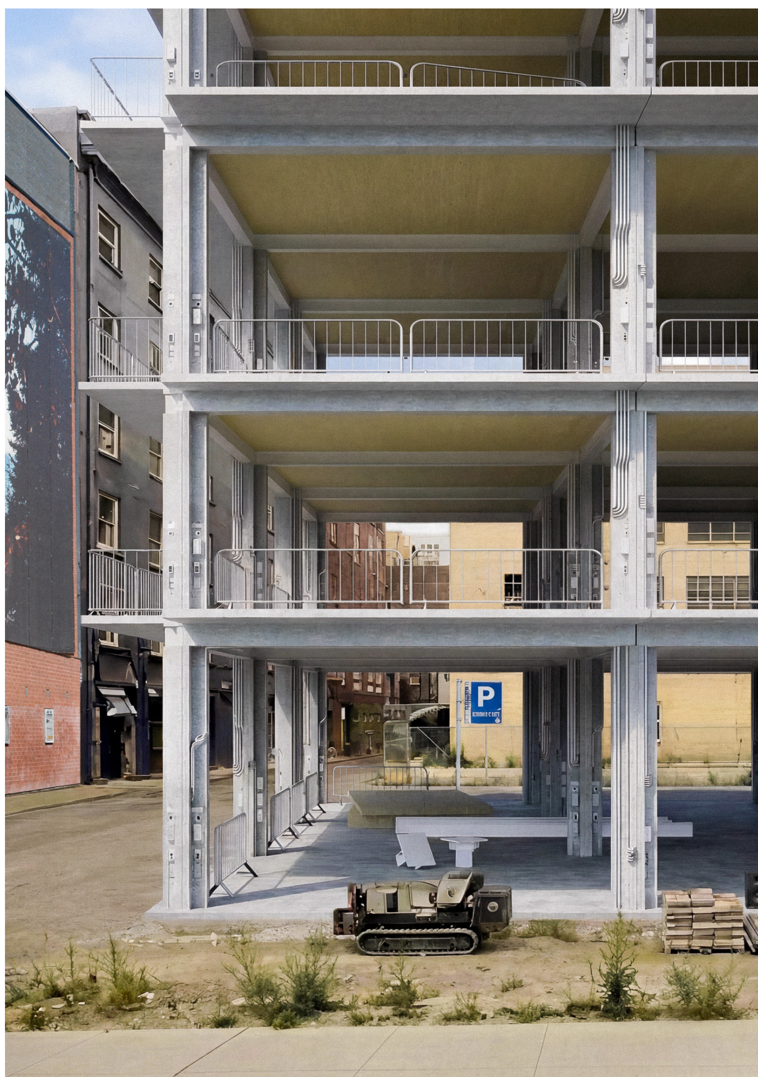
Fig. 7 En faire juste assez [Le support en construction]
