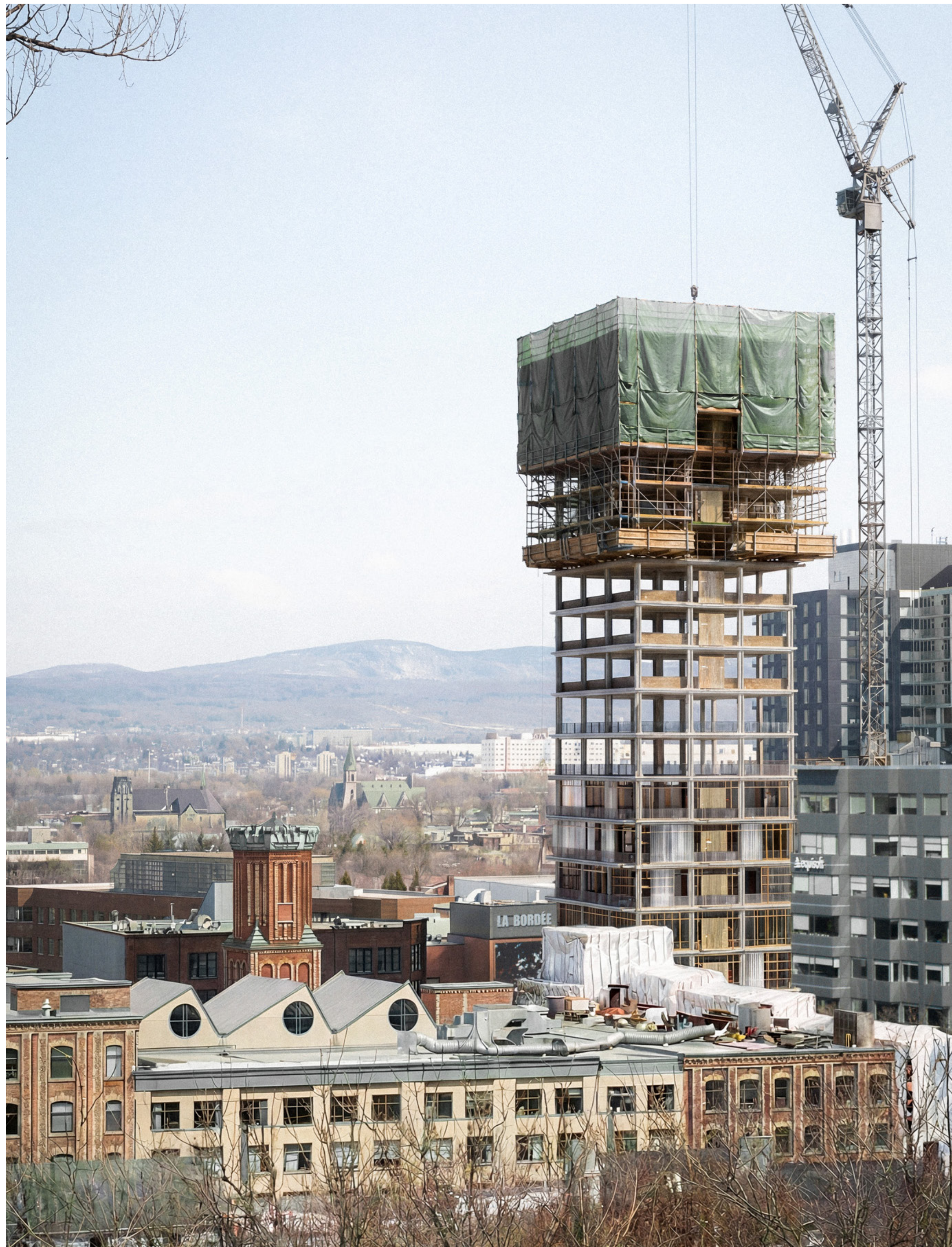
Fig. 1 Accepter que le projet est continuellement en devenir [Surélévation du support pour ajout d'étages de logements]
