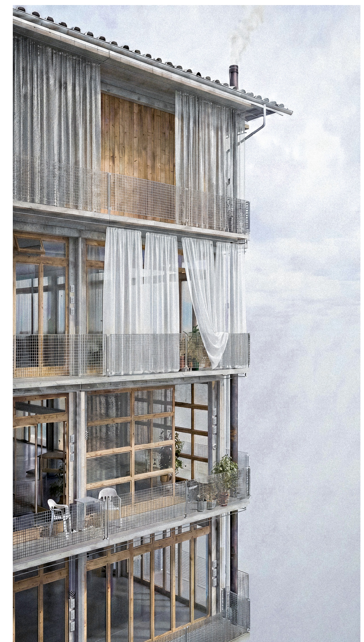
Fig. 9 Des ouvertures adaptées selon l'usage [La façade dans sa diversité]
