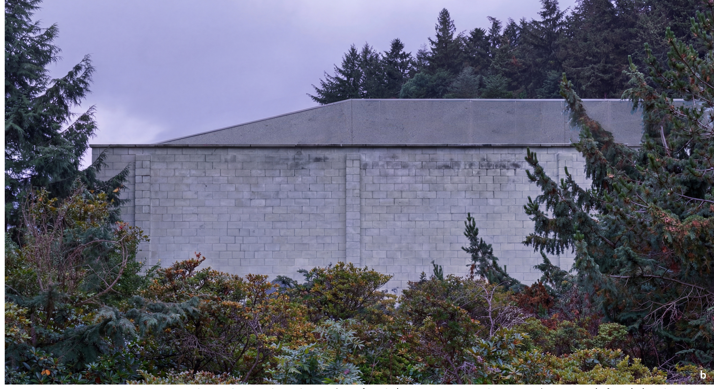
Les insectes s'inscrivent dans les infrastructures existantes de Namu, où la végétation s'est progressivement réinstallée.
